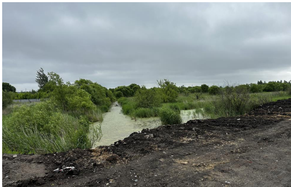
Земельный участок, расположенный в г. Уссурийске, по ул. Московская Фото Контрольно-счетной палаты Приморского края от 22.06.2026
