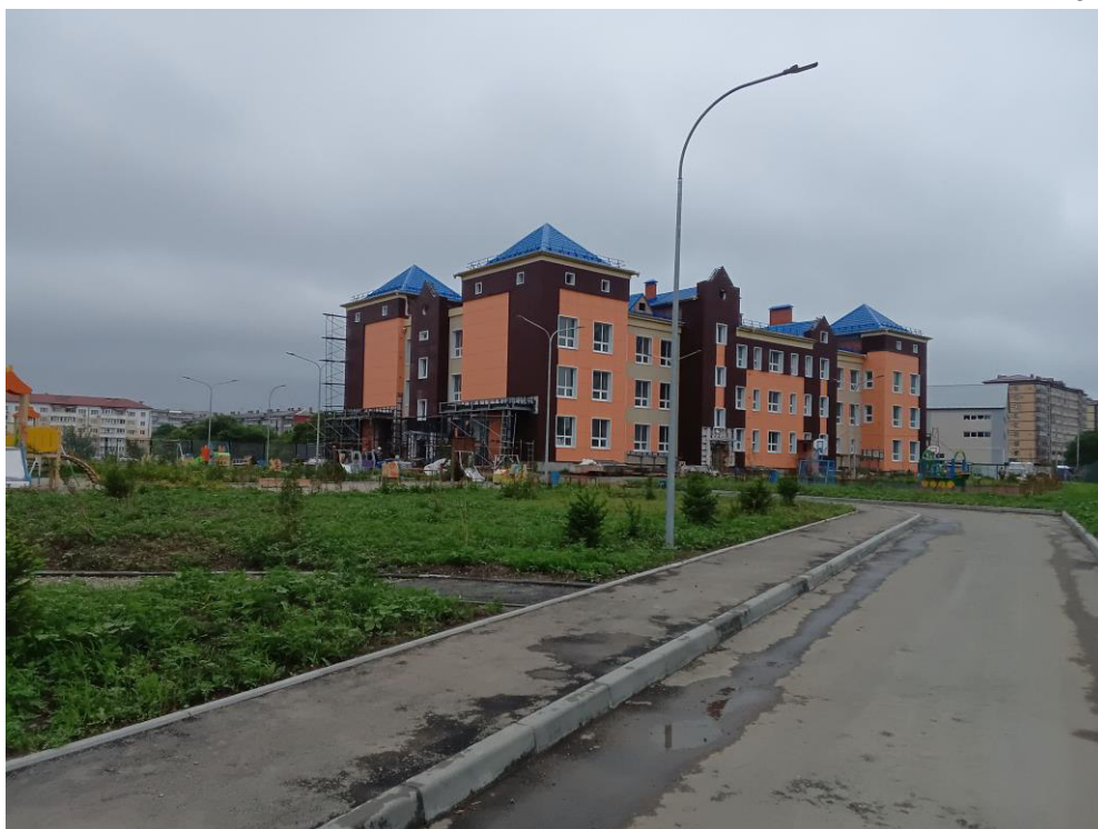
Объект строительства, расположенный в г. Уссурийске по ул. Выгонная, 1а Фото Контрольно-счетной палаты Приморского края от 22.06.2026
