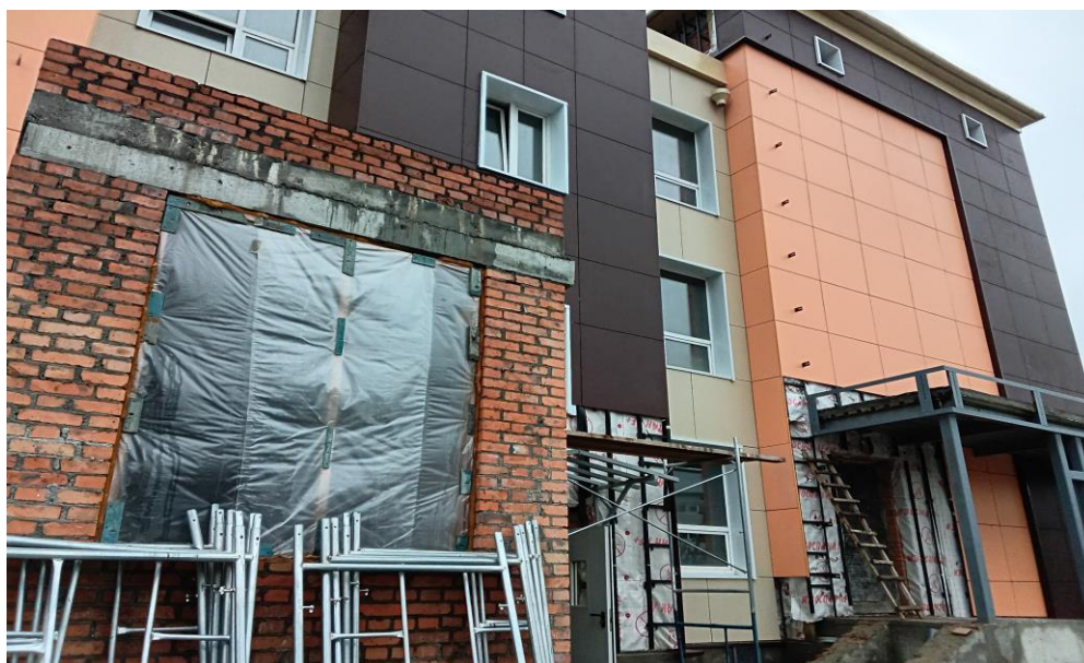
Объект строительства, расположенный в г. Уссурийске по ул. Выгонная, 1а Фото Контрольно-счетной палаты Приморского края от 22.06.2026
