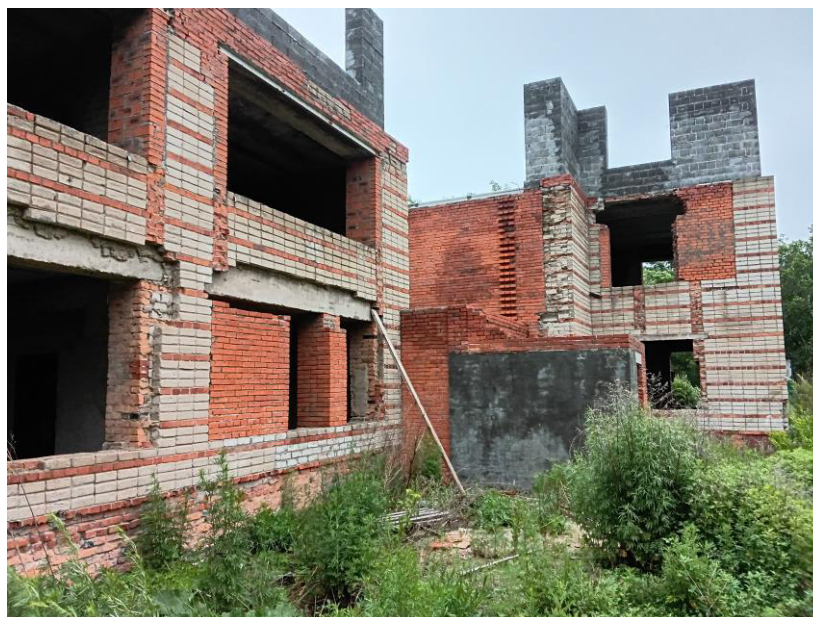
Объект реконструкции, расположенный по адресу: г. Уссурийск, ул. Промышленная, 5Д Фото Контрольно-счетной палаты 22.06.2026
