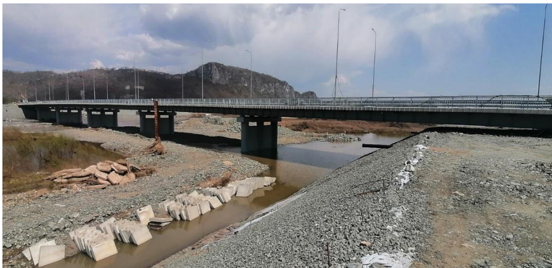
Общий вид моста через р. Партизанская. 2025 год Фото сделано сотрудниками Контрольно-счетной палаты Приморского края
