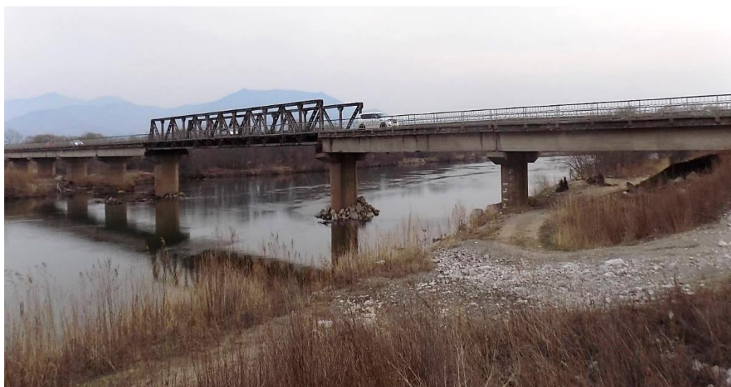
Общий вид моста через р. Партизанская. 2018 год Фото сделано сотрудниками Контрольно-счетной палаты Приморского края
