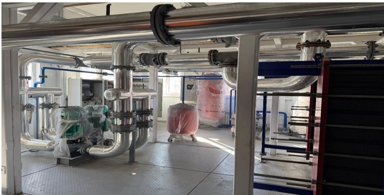
Строящаяся новая котельная
