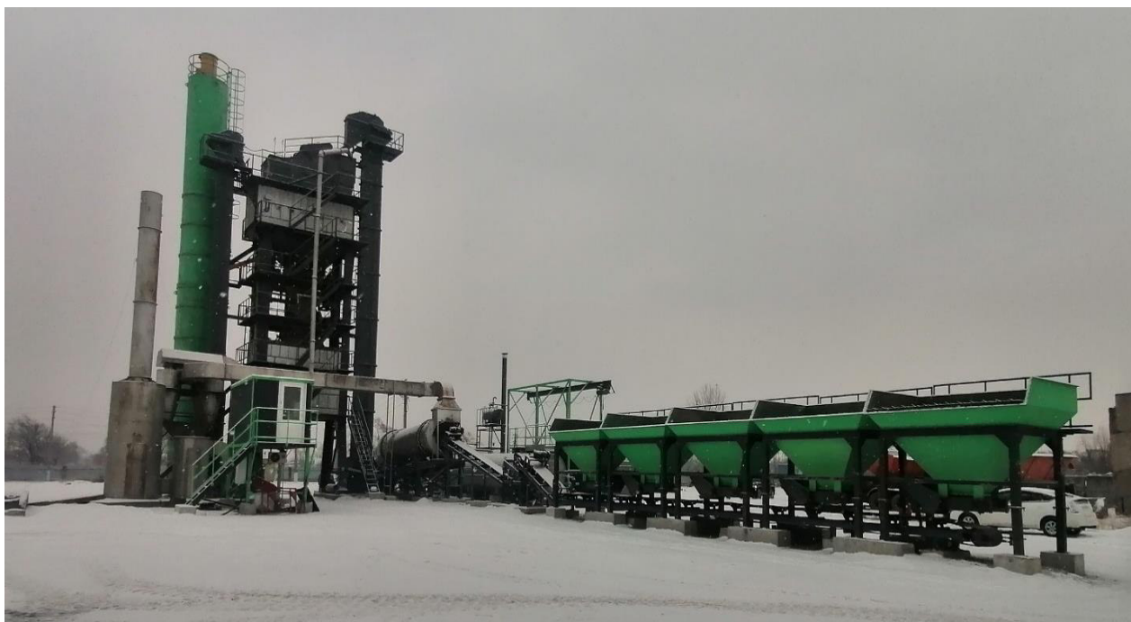
Асфальтобетонный завод (филиал «Никольский») (введен в эксплуатацию)
