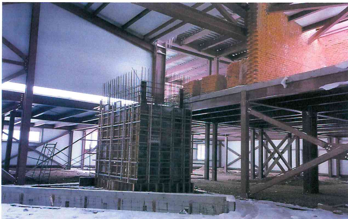
Шахта подъемника для МГН
