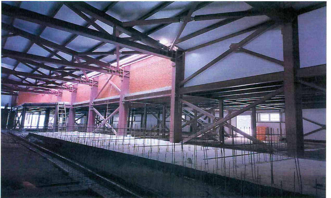
Фундамент под трибуны
