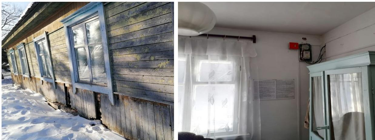
Фасад и помещения ФАПа с. Устиновка, фото сотрудников Учреждения 02.03.2023. На объекте недвижимости присутствуют трещины фундамента, разрушение нижних венцов несущих стен сруба в процессе гниения; перекос дверных проемов, зазоры оконных проемов; сколы и трещины шифера на крыше; в помещениях наблюдается отставание штукатурного слоя.
