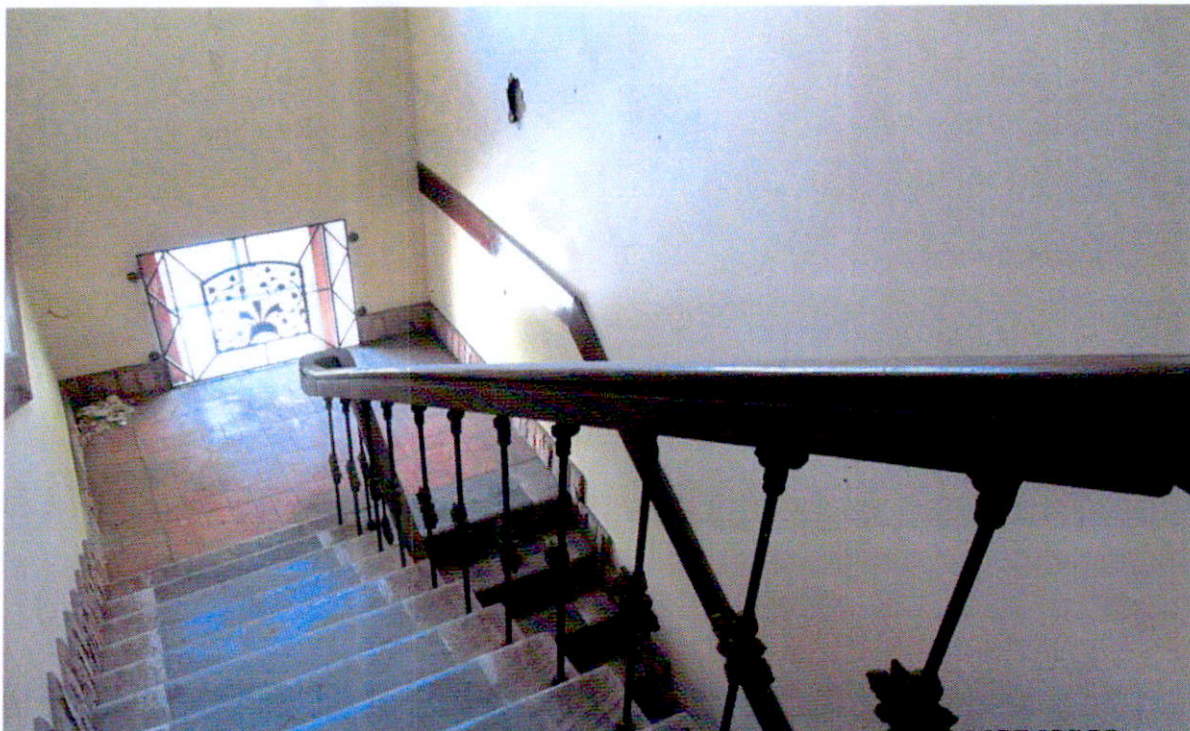
Фото 3. Внутренняя лестница с первоначальным ограждением
