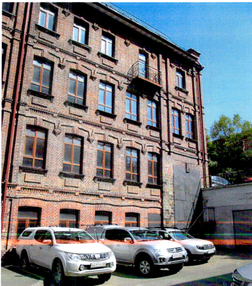
Фото 2. Юго-восточный фасад здания
