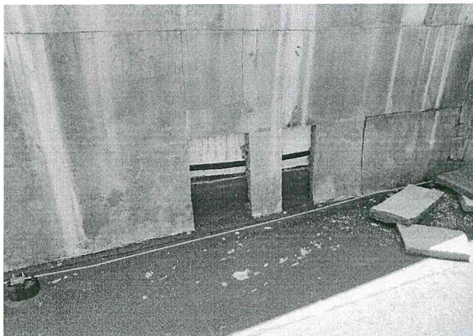
Состояние крыши здания гребной базы ((г. Партизанск, ул. Чкалова, 1Г) Фото Контрольно-счетной палаты Приморского края от 24.05.2023
