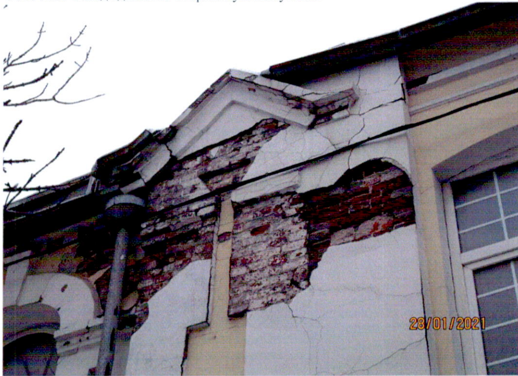
Фото №2. Фасад здания со стороны ул. Алеутская
