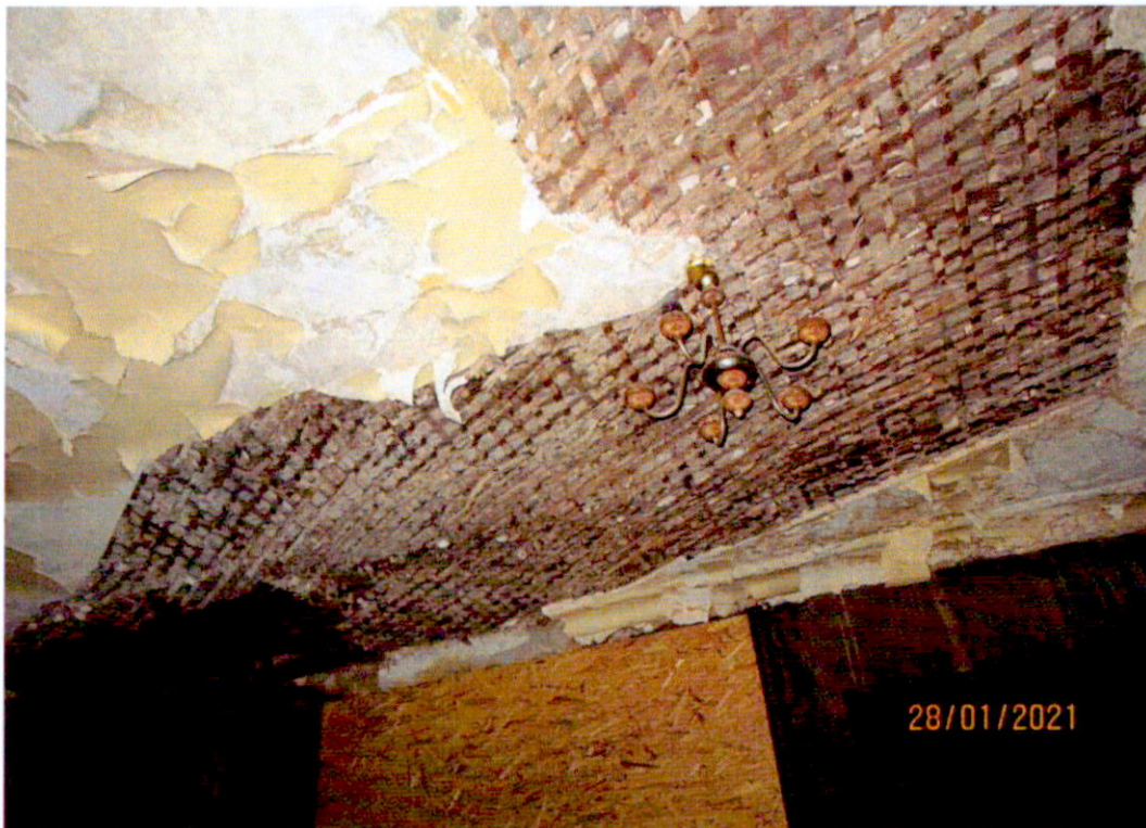
Фото № 6,7,8,9. Фрагменты внутренних помещений
