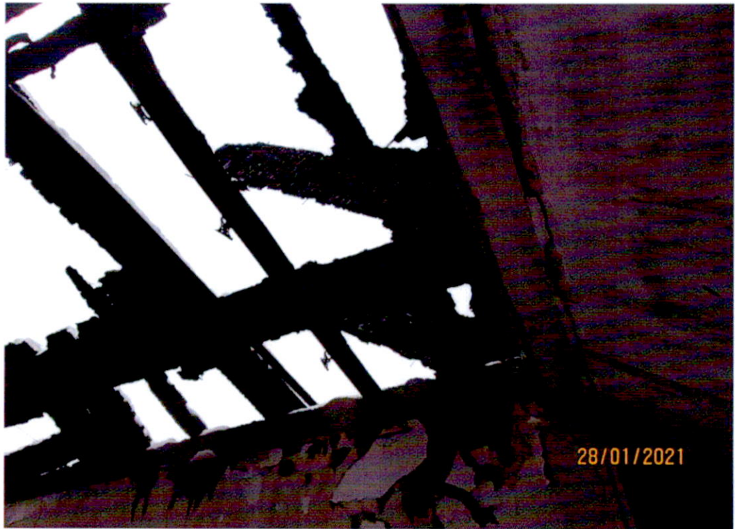
Фото № 12,13. Фрагменты крыши
