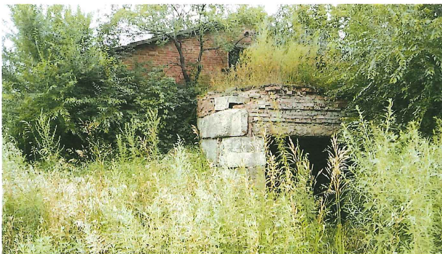
Здания картофелехранилищ (г. Уссурийск, ул. Дальневосточная, 23/2, 23/3).
