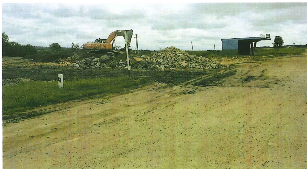
Автомобильная дорога Подъезд к с. Покровка от Галенки – Новогеоргиевка
