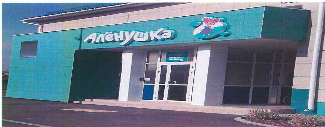
Здание МБДОУ № 1 с. Чугуевка
