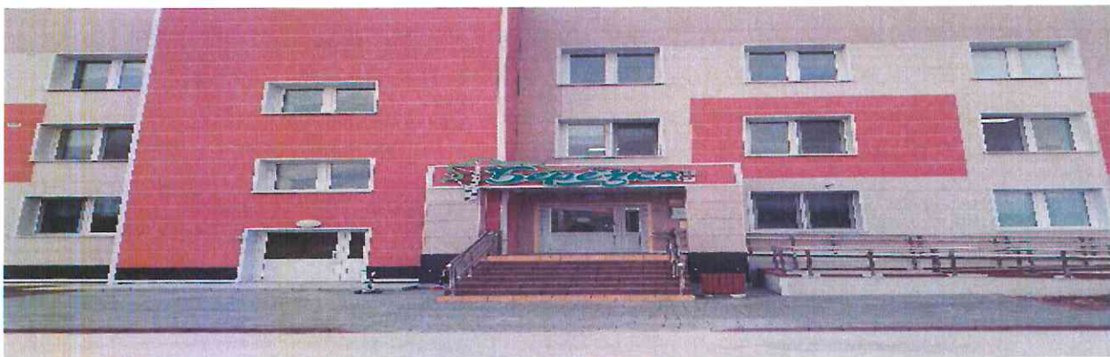
Здание МБДОУ «Детский сад № 4 «Березка»
