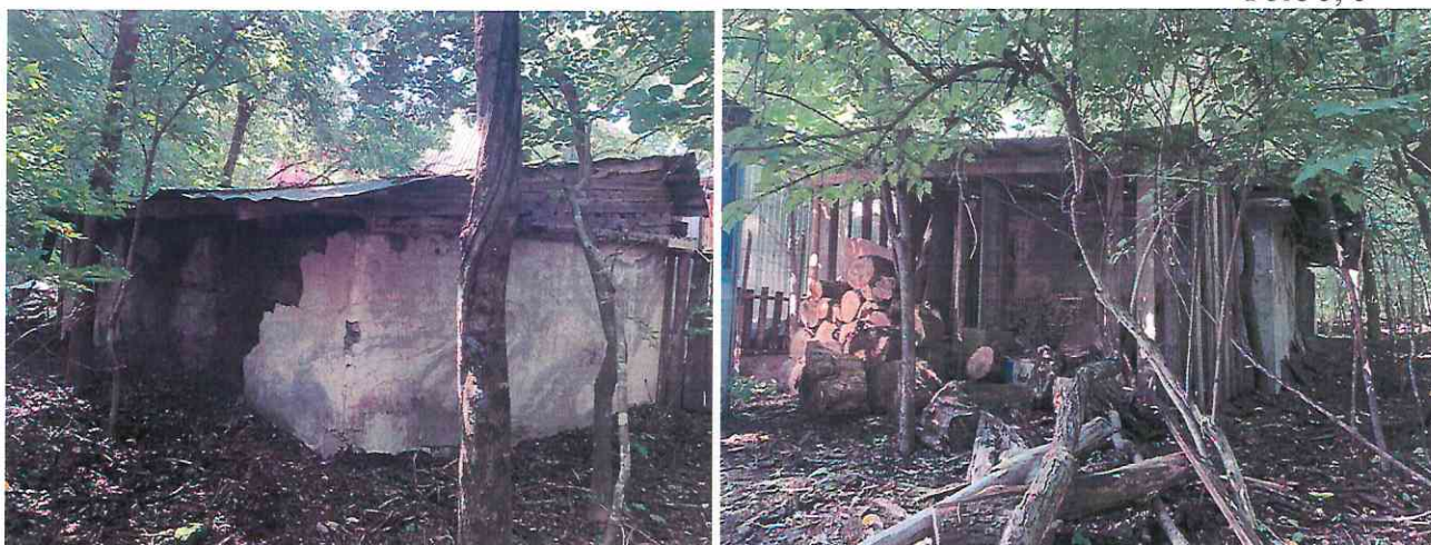
Здание водоканализационной станции: г. Партизанск, ул. Первомайская, 3а Фото Контрольно-счетной палаты Приморского края 10.08.2022
