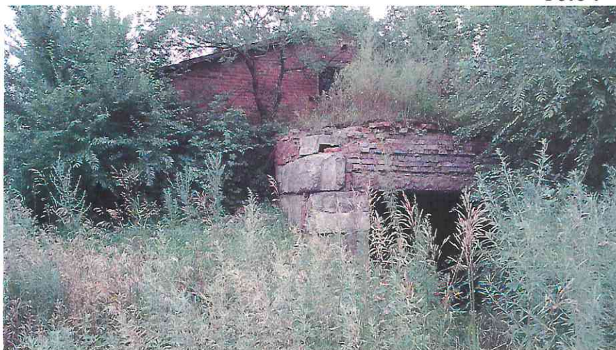
Здания картофелехранилищ (г. Уссурийск, ул. Дальневосточная, 23/2, 23/3).
