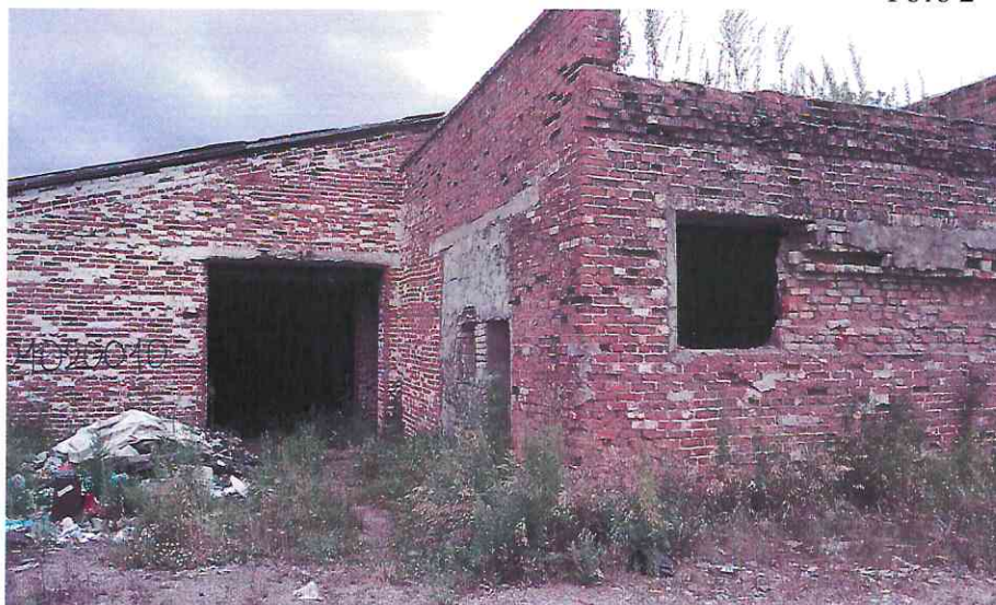
Коровник на 200 голов (г. Уссурийск, ул. Дальневосточная, 34) Фото Контрольно-счетной палаты Приморского края от 05.08.2022
