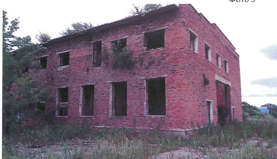
Ремонтная мастерская (г. Уссурийск, ул. Дальневосточная, 28а). Фото Контрольно-счетной палаты Приморского края от 05.08.2022
