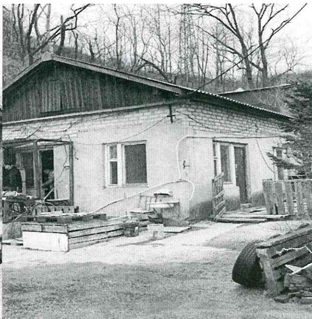
Контора, г. Владивосток, ул. Капитана Шефнера, д.22 Фото Контрольно-счетной палаты Приморского края от 07.04.2022
