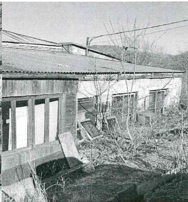
Здание – бойлерная, лит.1. Фото Контрольно-счетной палаты Приморского края от 02.03.2022
