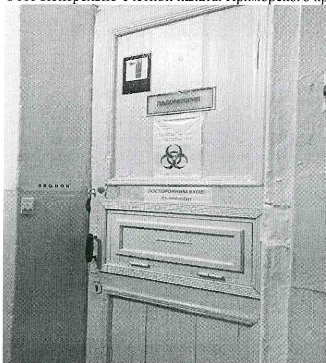
Вход в баклабораторию Приморский край, г. Уссурийск, ул. Пушкина, 35 Фото Контрольно-счетной палаты Приморского края от 05.04.2022
