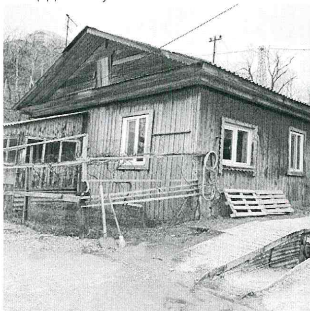
Одноэтажное здание с подвалом и пристройкой, г. Владивосток, ул. Капитана Шефнера, д.22 Фото Контрольно-счетной палаты Приморского края от 07.04.2022
