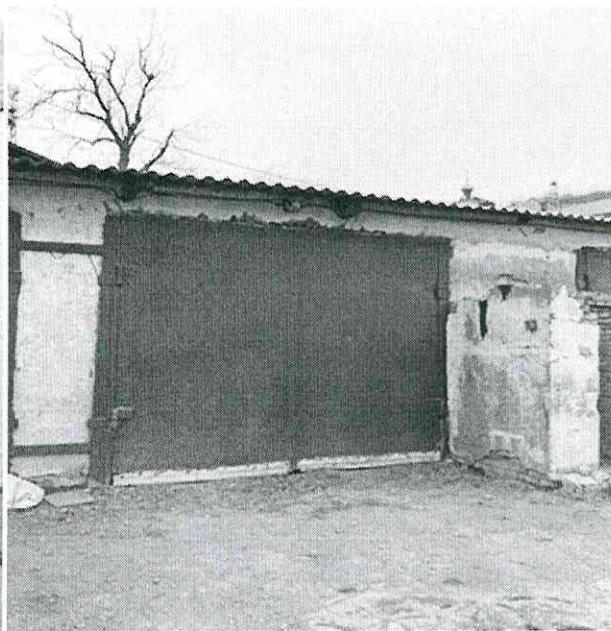
Гараж-склад, К. Шефнера, д. 22 Фото Контрольно-счетной палаты Приморского края от 07.04.2022
