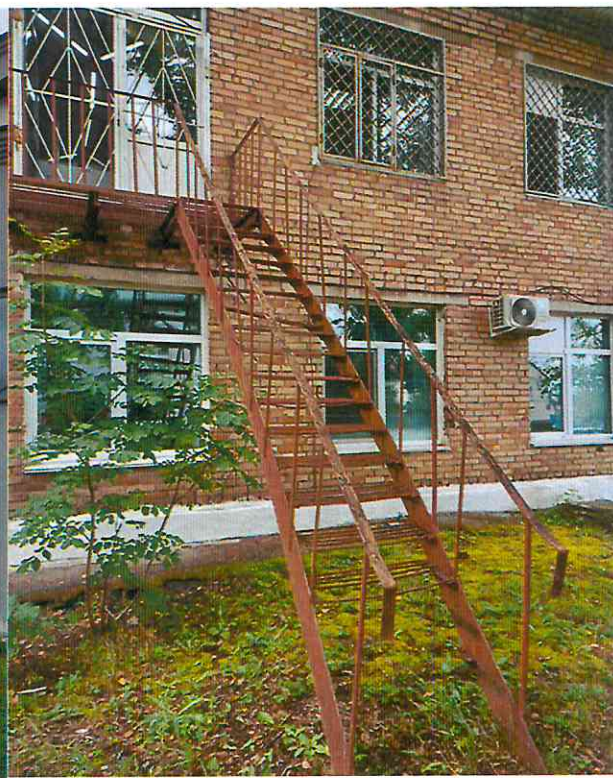
Общий вид фасада Здание больницы п. Трудовое, ул. Энгельса, 7, год постройки – 1962. Требуется: замена систем водоснабжения, теплоснабжения и электроснабжения, ремонт фасада, общестроительные работы, замена внутреннего пожарного водопровода, ремонт эксплуатационных пожарных лестниц.
