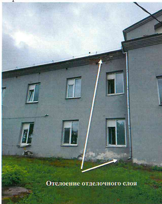
Общий вид фасада Поликлиника п. Трудовое, ул. Энгельса, 7, год постройки – 1968. Требуется: замена систем водоснабжения, теплоснабжения и электроснабжения, ремонт фасада, общестроительные работы, замена внутреннего пожарного водопровода, устройство теплого тамбура. Количество прикрепленного населения – 13 002 человек, количество плановых посещений в смену – 123; площадь обслуживаемой территории – 100 кв. км, радиус обслуживания – 5 км; расстояние до МО 2-го уровня – 28 км.
