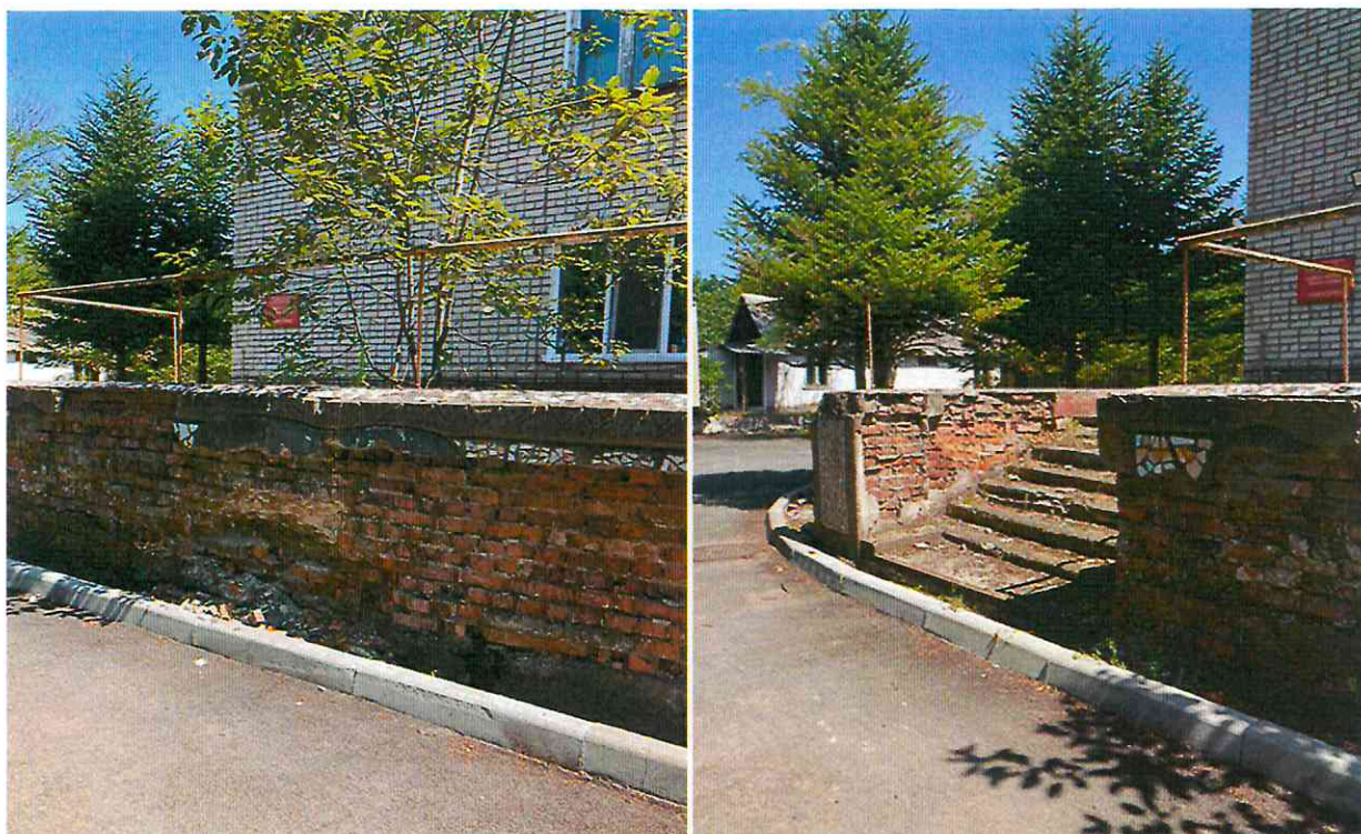
Общий вид фасада здания лабораторного корпуса КГБУЗ «Хасанская центральная районная больница» п. Славянка, ул. Дружбы, 5, дата ввода в эксплуатацию – 01.01.1985. Фото Контрольно-счетной палаты Приморского края от 18.08.2021
