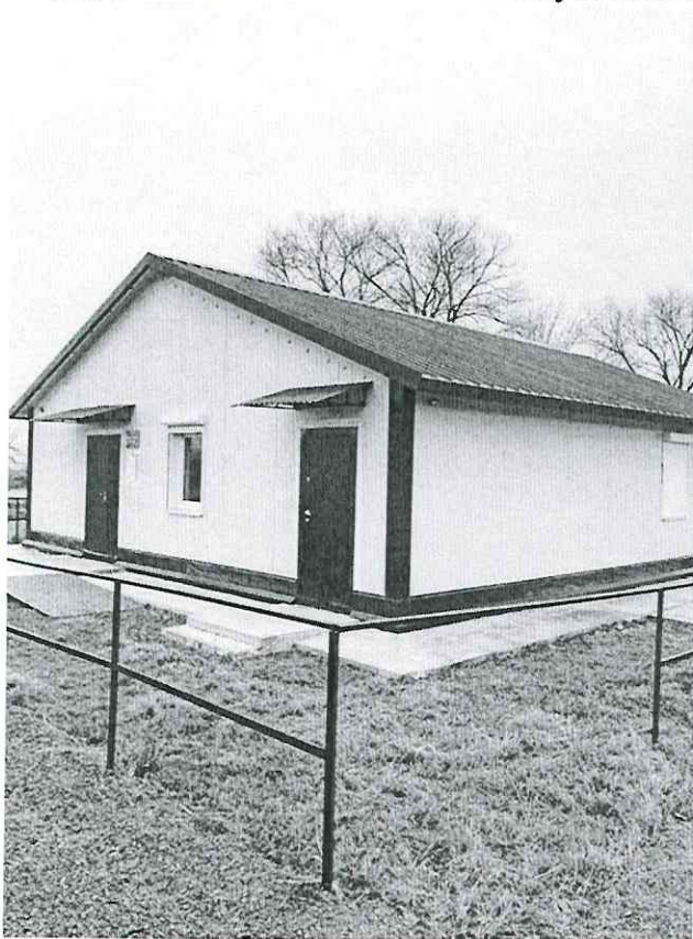
Фасад здания фельдшерско-акушерского пункта в с. Тереховка
