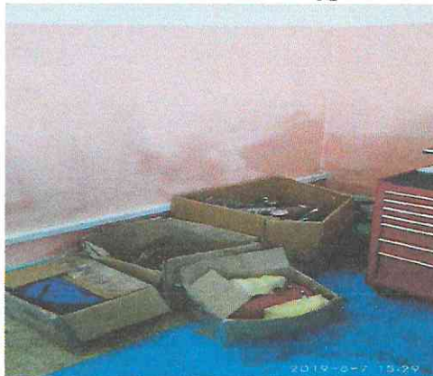
Мокрые стены после дождя (плесень на коробках)
