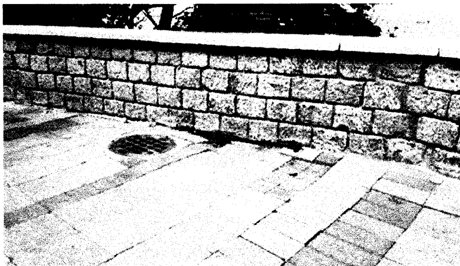
Состояние территории после ремонта (фото сделано сотрудниками Контрольно-счетной палаты города Владивостока 21.06.2019)
