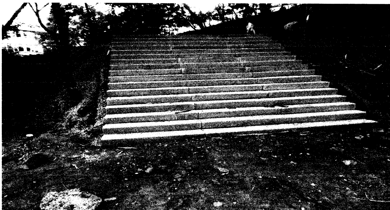
Состояние лестницы к спортивной (костровой) площадке после ремонта
