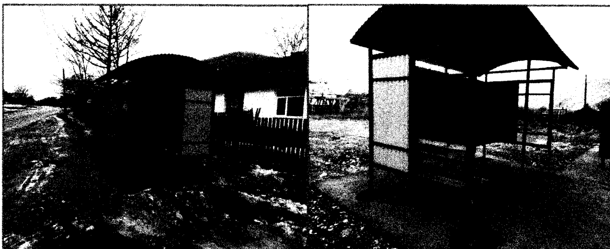
Автопавильон на а/дороге Дальнегорск – Краснореченск км 3+830
