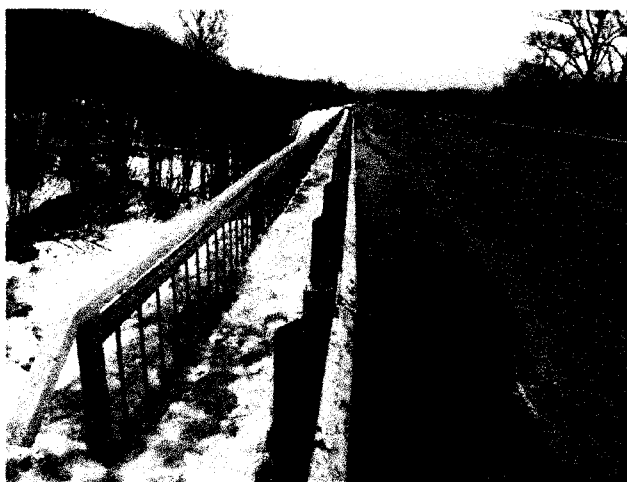
Мост через р. Тигровый
