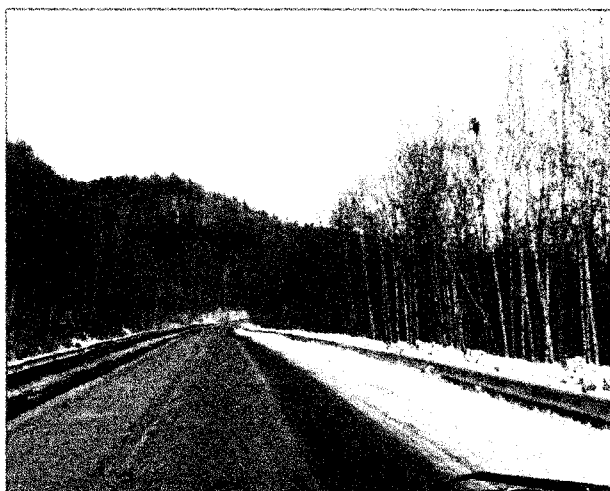
Снег перед барьерным ограждением
