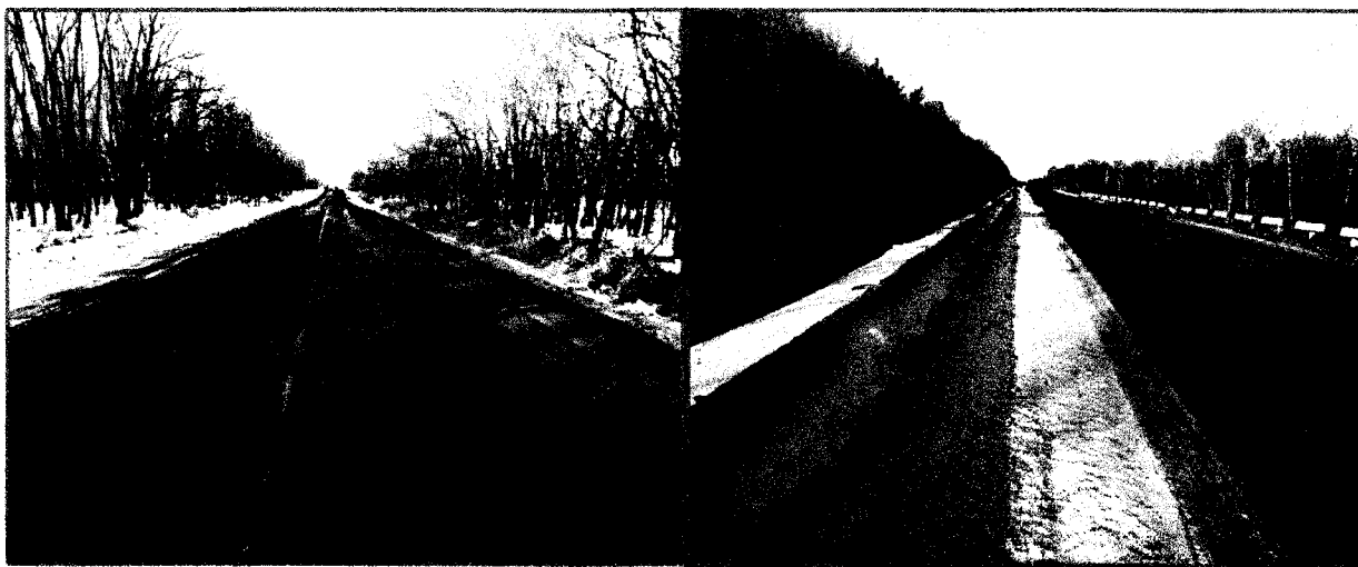
Разрушенное покрытие дороги на км 16 Снег перед барьерным ограждением на км 42
